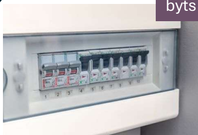
En ny elcentral monteras i lägenheten
