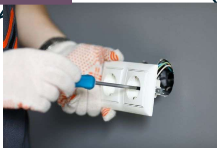
Nya eluttag installeras
